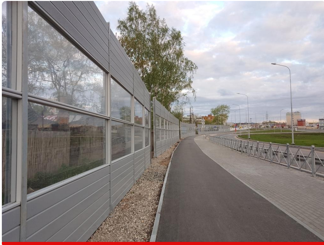
Объект: Строительство а/д «Переход ул. Строителей – Площадь Гайдара» г. Пермь
