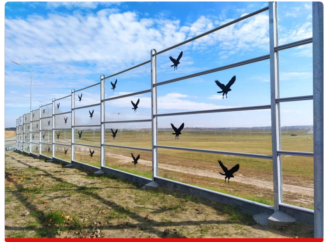
Объект: Автомобильная дорога Р-23 и Р-53 Республика Беларусь
