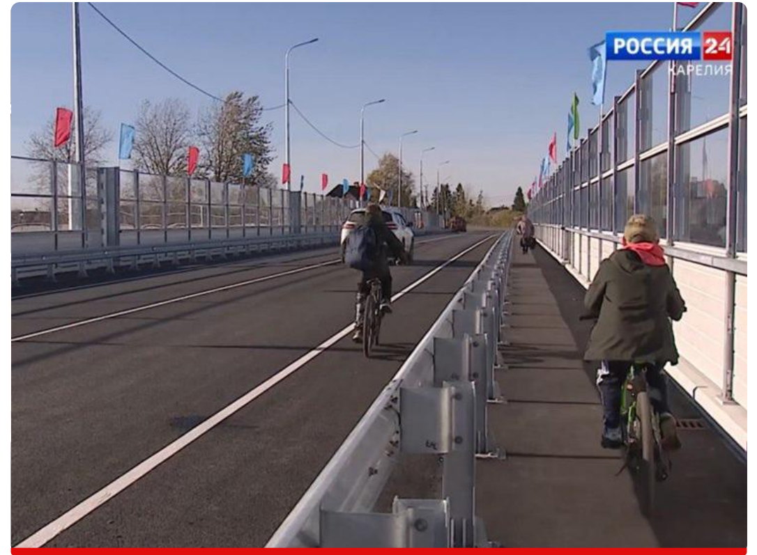
Объект: Строительство мостового перехода через реку Шуя Республика Карелия
