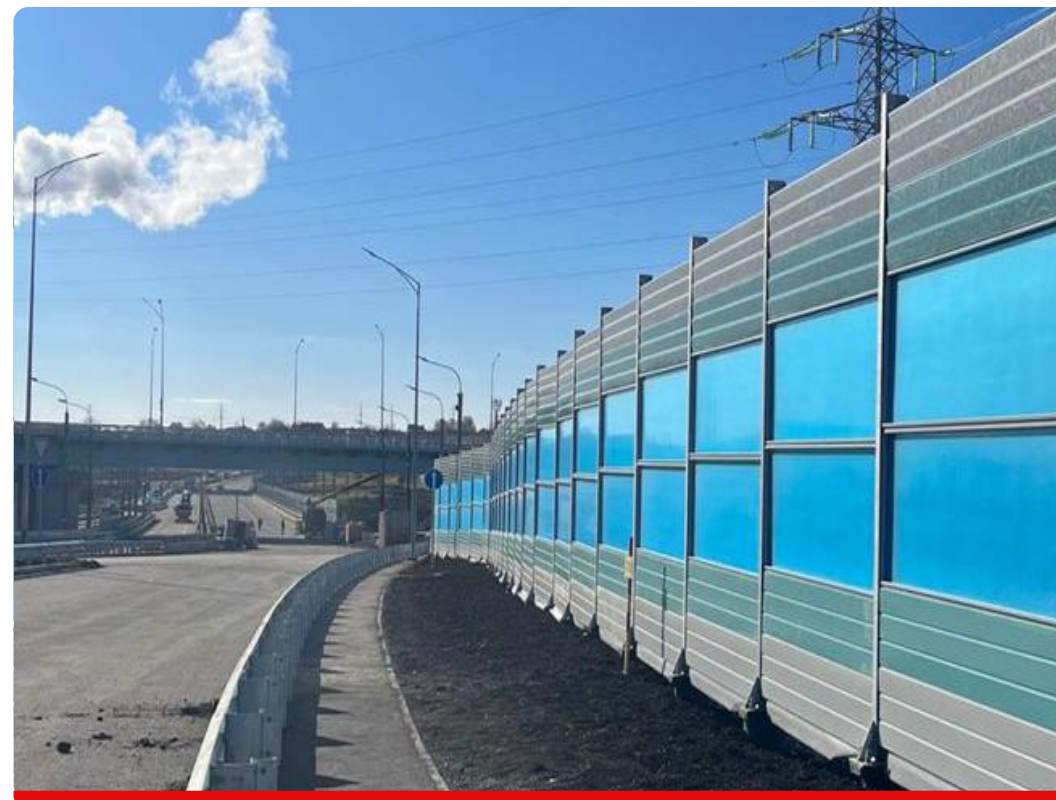
Объект: Строительство а/д Переход ул. Старцева – пр. Октябрат – ул. Целинная. Этап 1
