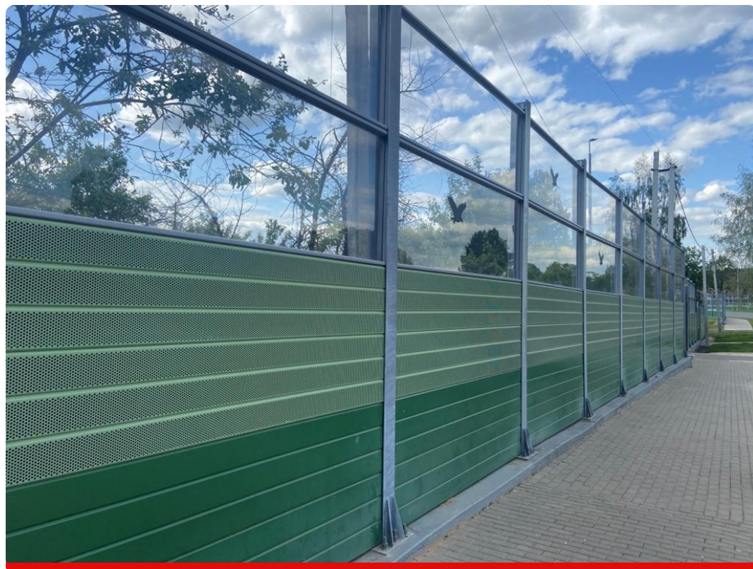
Объект: Строительство автомобильной дороги Воскресенское-Каракашево- Щербинка
